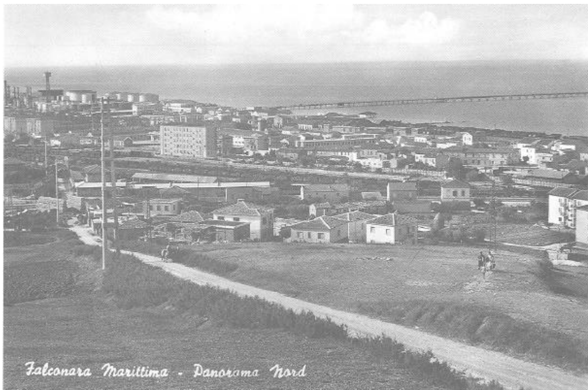
Foto 7 - Località: Falconara Alta. Periodo: circa 1960. Panoramica del versante costiero in direzione di Villanova e della raffineria API. (Foto tratta da: Falconara, Storie e immagini. A cura di Giuseppe Campana, Giorgio Marinelli, Gilberto Piccinini & Sirio Sebastianelli. 1989 – Ed. Comune di Falconara Marittima)
